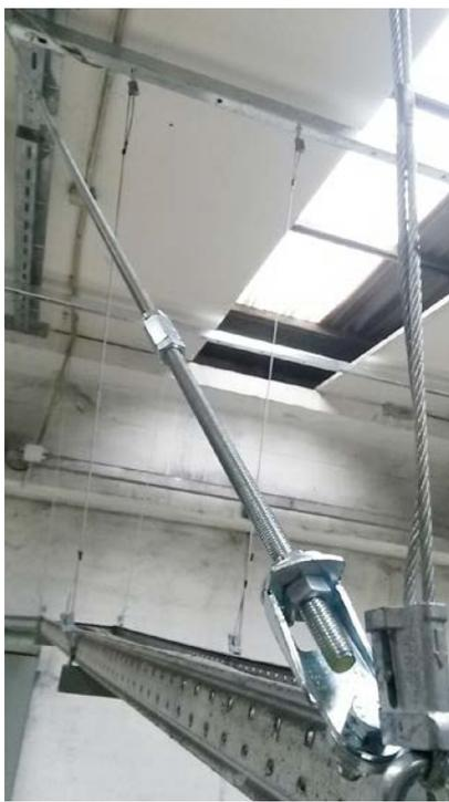
PARTICOLARE DI ANCORAGGIO SISMICO
